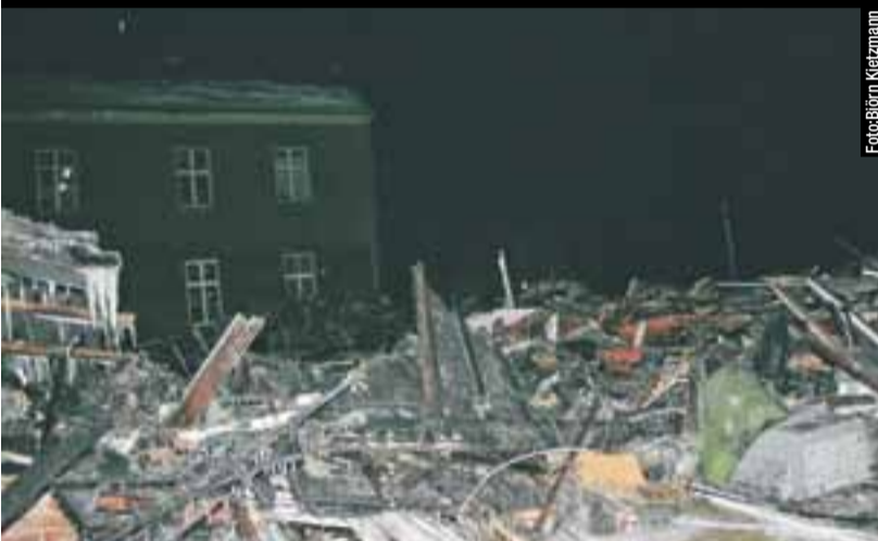
Das 2010 abgebrannte Haus der Demokratie in Zossen (Brandenburg)
