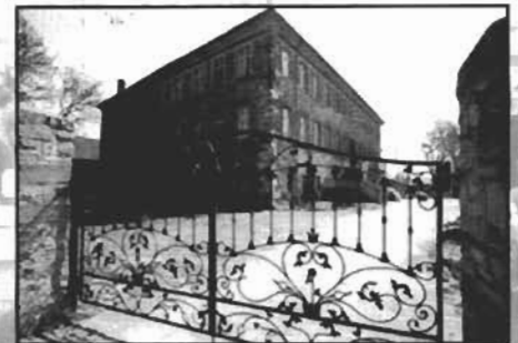
In Trebnitz wird ein ehemaliges Schloss zum Schulungszentrum umgebaut
