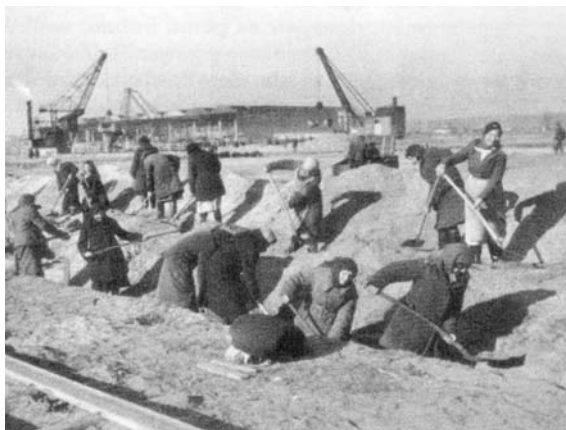
Sowjetische Zwangsarbeiterinnen bei Erdarbeiten am Diestelkai Bild: LBSt HH
